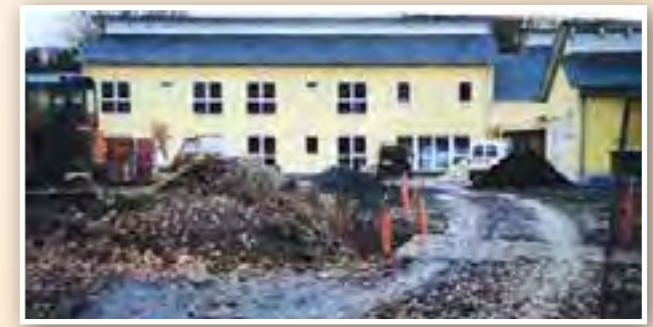
2009/2010 Neubau Tagesförderstätte und Apartmenthaus
