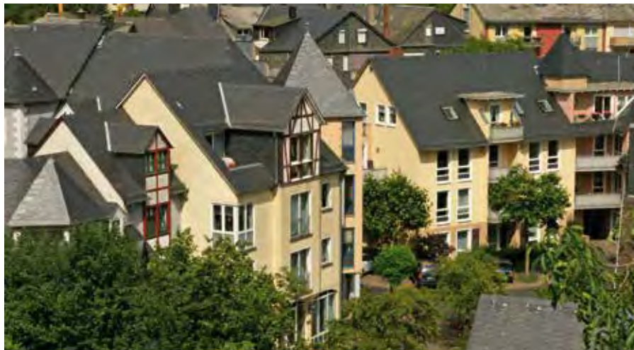
Eingebettet in die Altstadt von Kastellaun befinden sich die Häuser burgfried I (li.), burgfried II (re.) und das Haus am Stadtgraben (nicht im Bild) mit insgesamt 45 altersgerechten Wohnungen.
